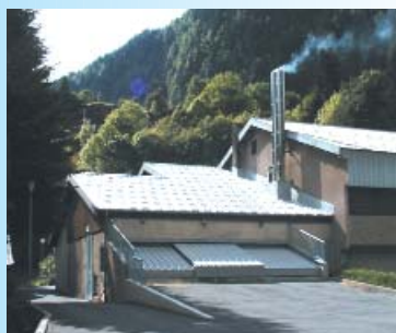
Vue de la trappe de livraison du silo d'alimentation.
