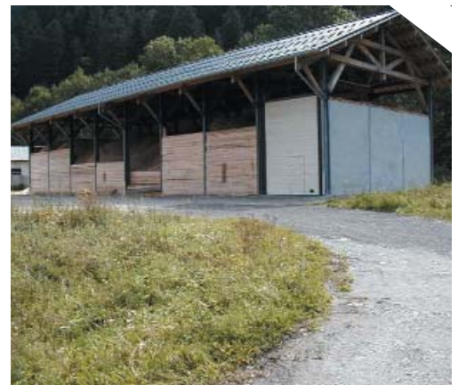
Hangar de stockage de 2 000 m 3 .
