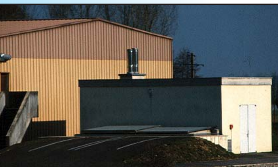
Vue de la chaufferie.
