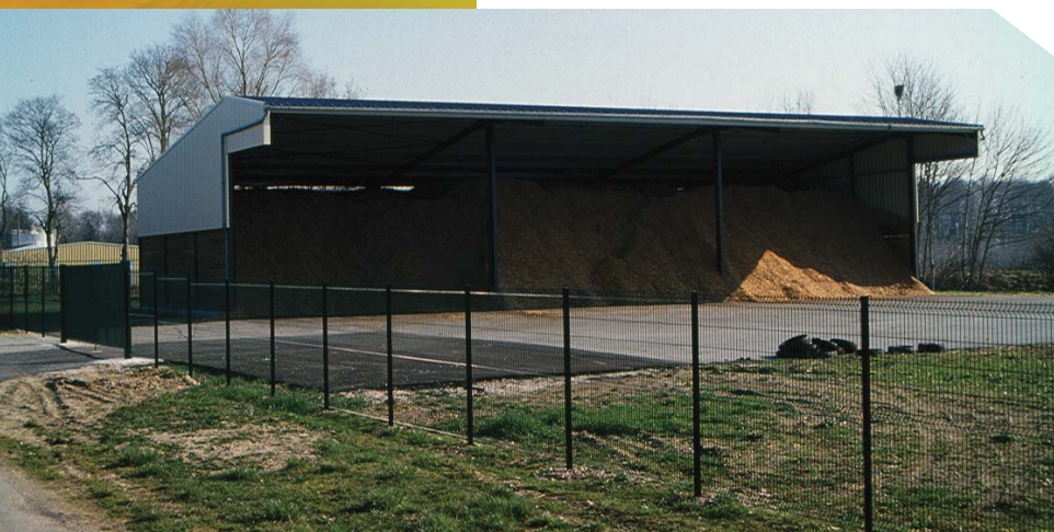
Hangar de stockage du bois déchiqueté.
