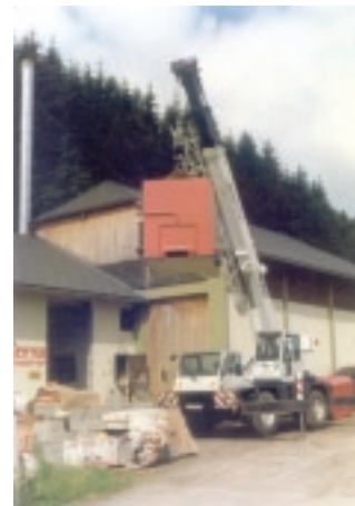
Einbau des 2. Kessels: Möderbrugg 1992
