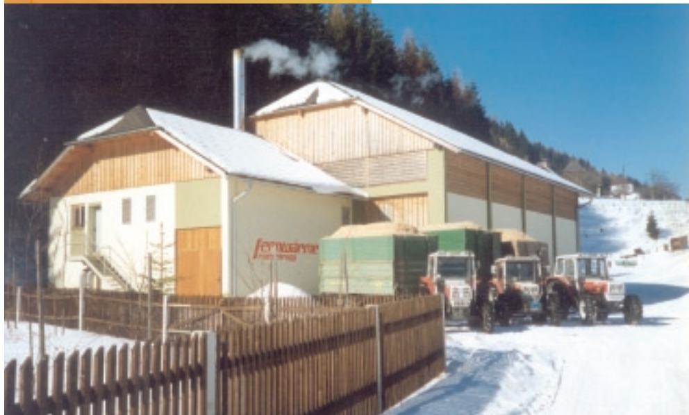
Das Heizhaus im Ortsteil Möderbrugg: 2 Heizkessel der Firma Kohlbach mit der Gesamtleistung von 1,8 MW
