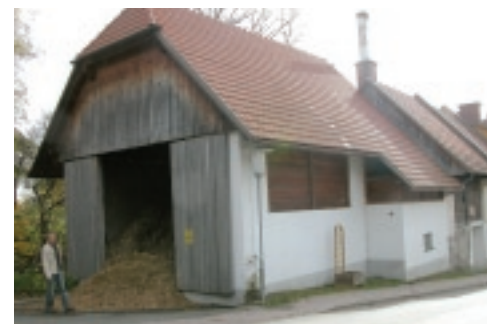
St. Oswald: Lager mit Heizhaus
