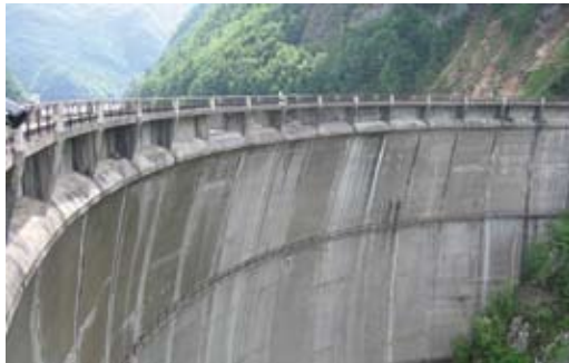
14/14a. Diga di Speccheri, parte dell'impianto idroelettrico di Maso Corona in Trentino (source: AGSM).
