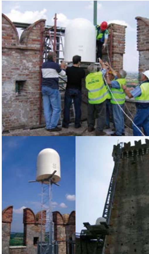
6. Installazione di un radar in banda X a scansione orizzontale a Valeggio sul Mincio (fonte: ARPAV).
