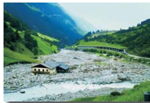
Durch Muren kann es wie hier 1987 im Stubaital zu massiven Schäden an Siedlungen und Straßen kommen.
